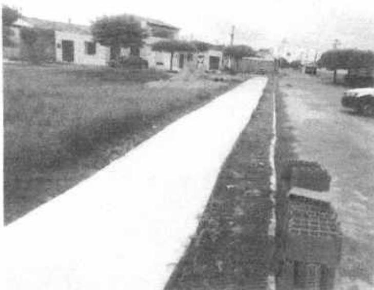
Foto 02 - Laje pré fabricada em concreto
