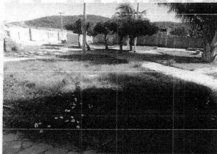
Foto 02: Local da reforma
