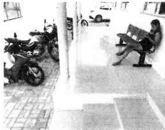
Foto 01: Piso a ser removido e substituído em função de quedas constantes no período chuvosos
