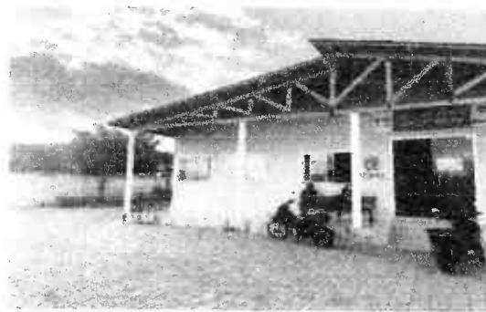
Foto 05: Fachada da edificação
