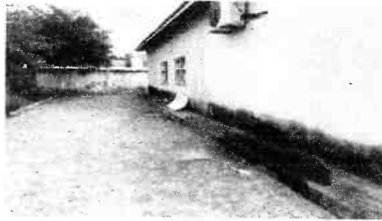
Foto 03: Pintura externa com elevado bolor
