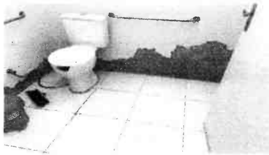
Foto 04: Pulverulência da argamassa nos locais oriundos da manifestação de umidade por capilaridade.
