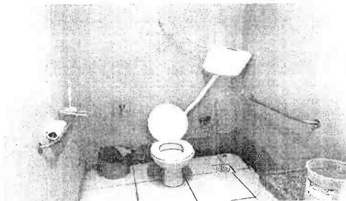
Foto 01: Banheiro com elevada quantidade de infiltrações e ausência de revestimento cerâmico
