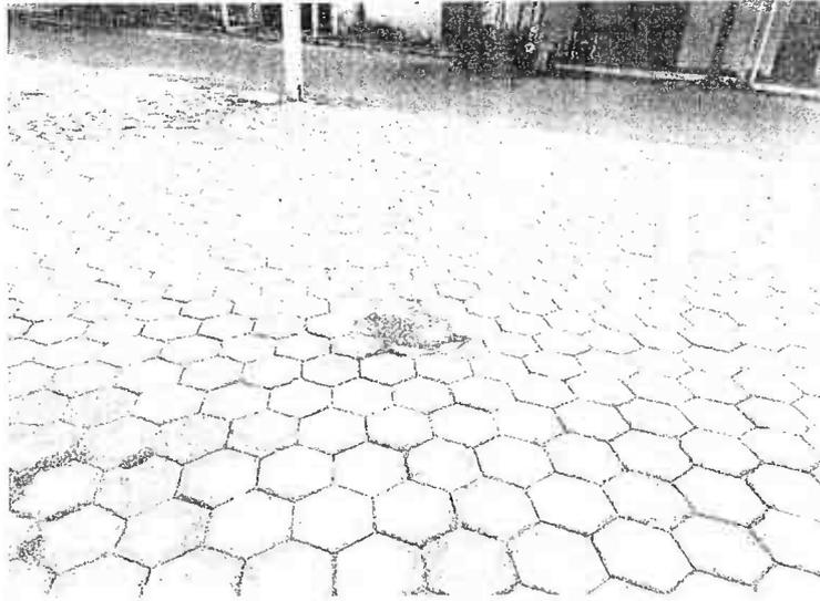
Foto 06: Pavimento sextravado trincado
