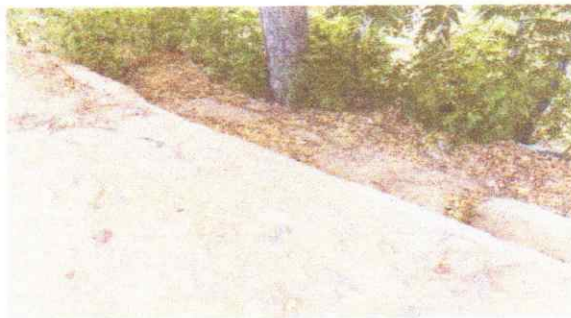
Foto 05: Situação do meio fio existente na avenida
