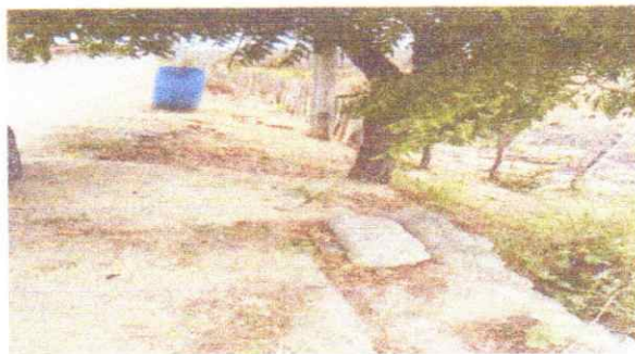
Foto 03: Situação do meio fio existente na avenida
