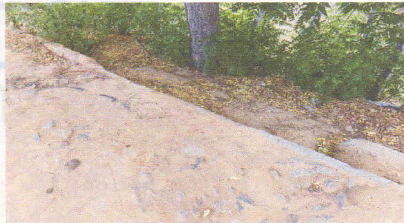
Foto 05: Situação do meio fio existente na avenida
