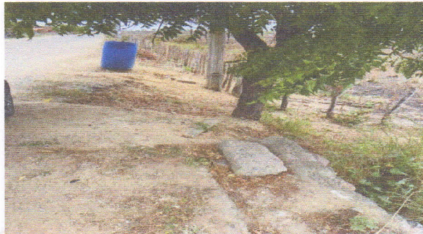
Foto 03: Situação do meio fio existente na avenida
