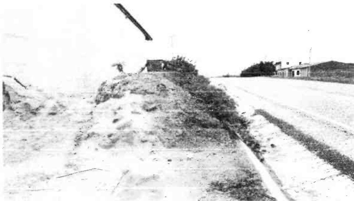
Foto 03: Trecho E-F do local de implantação da obra(ÁREA DE PAVIMENTAÇÃO)
