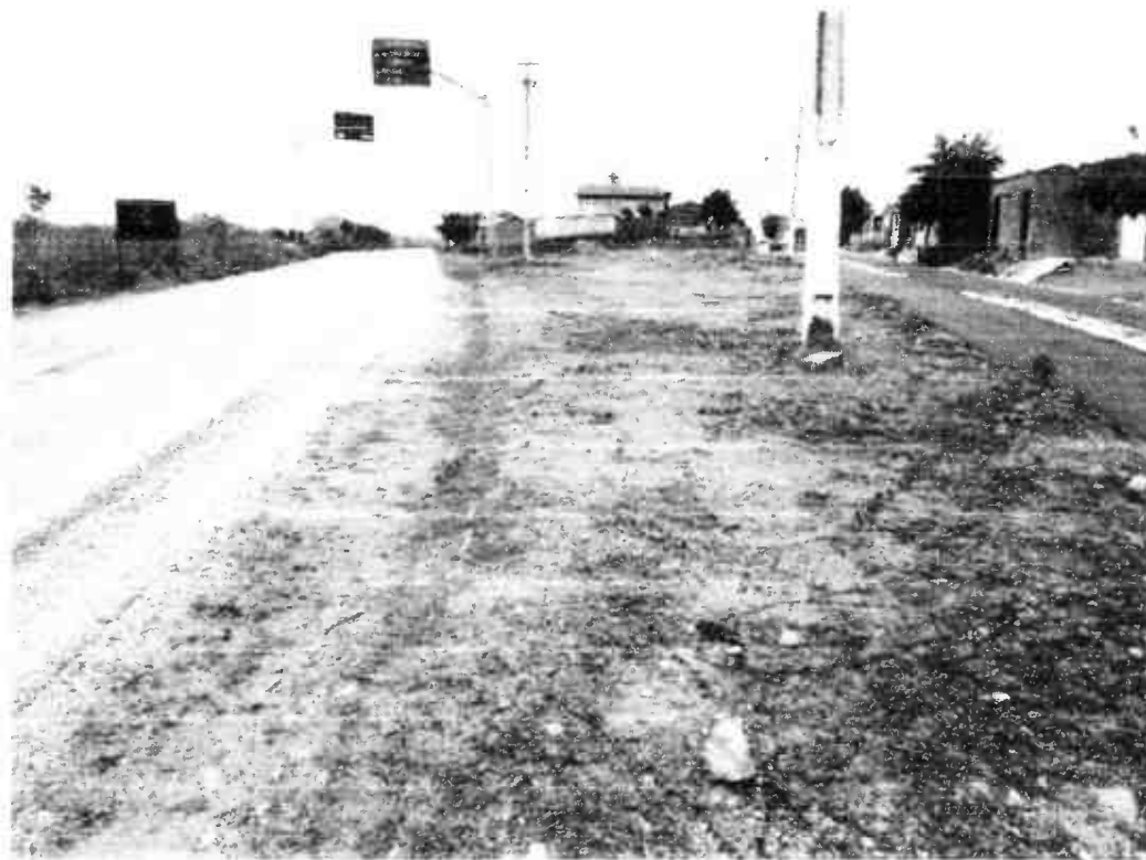
Foto 01: Trecho A-B do local de implantação da obra(ÁREA DE PAVIMENTAÇÃO)
