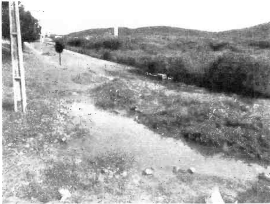
Foto 02: Rua a ser realizado o aterro e recomposição.
