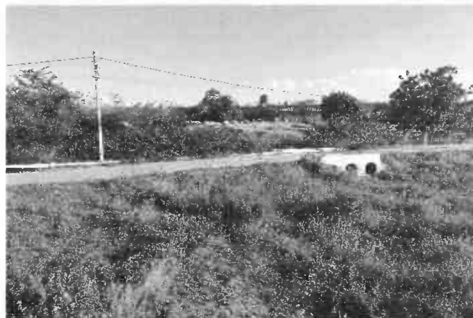
Foto 04: Via a ser urbanizada e ampliação da drenagem
