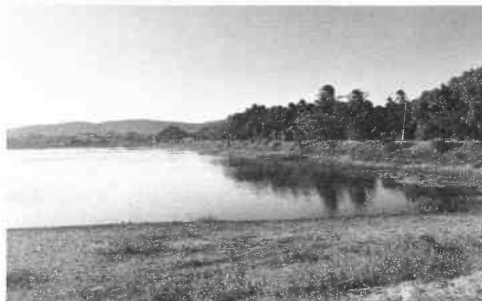
Foto 05: Talude de montante a ser recuperado
