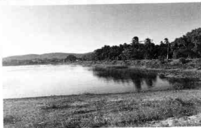
Foto 05: Talude de montante a ser recuperado
