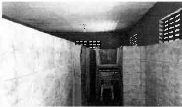
Foto 04: Área dos banheiros
