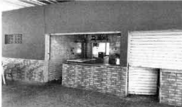
Foto 05: Fachada do rodoviária
