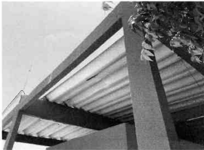
Foto 01: Estrutura de concreto armado a ser demolida
