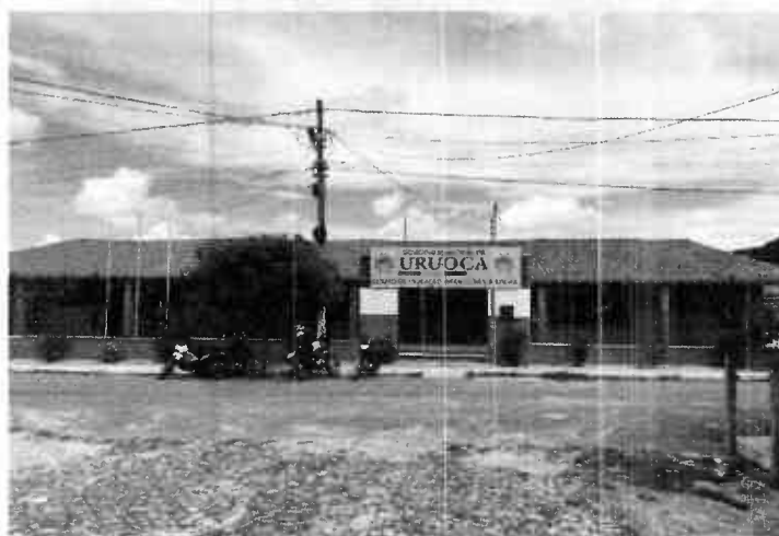
Foto 01: Fachada da edificação
