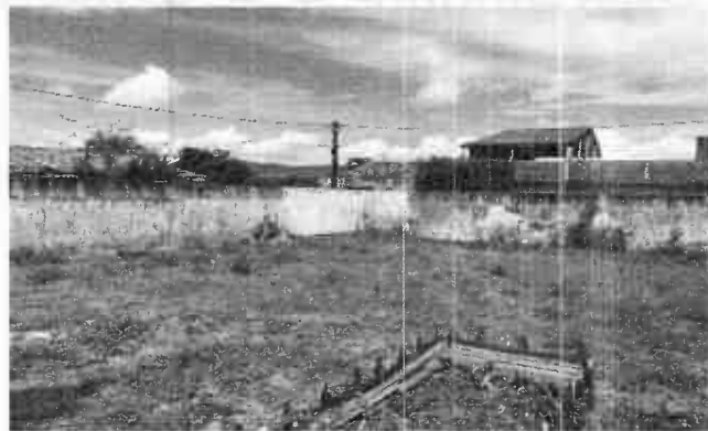
Foto 06: Área lateral esquerda destinada a implantação do bloco educacional
