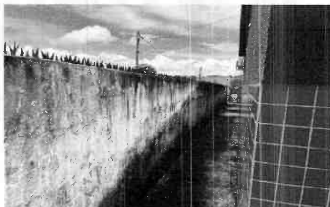
Foto 02: Muro a ser demolido para acesso a ampliação
