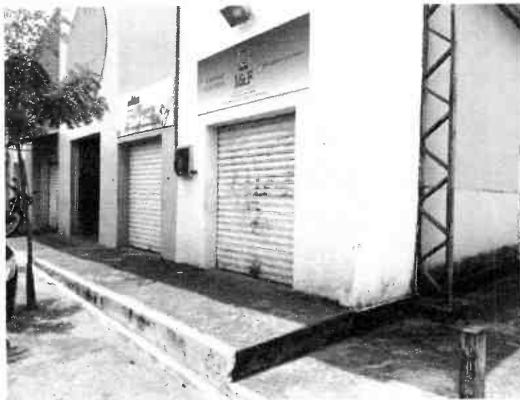
Foto 05: Permissionários sem individualização da medição de energia
