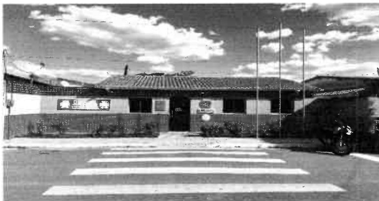
Foto 01: Fachada da edificação
