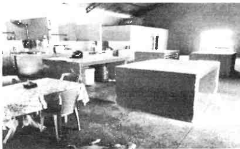
Foto 01: Salão da edificação
