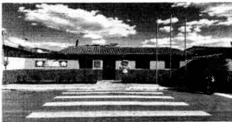
Foto 01: Fachada da edificação
