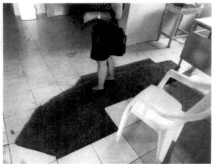
Foto 08: Em todo o prédio é apresentado deslocamento de cerâmicas.
