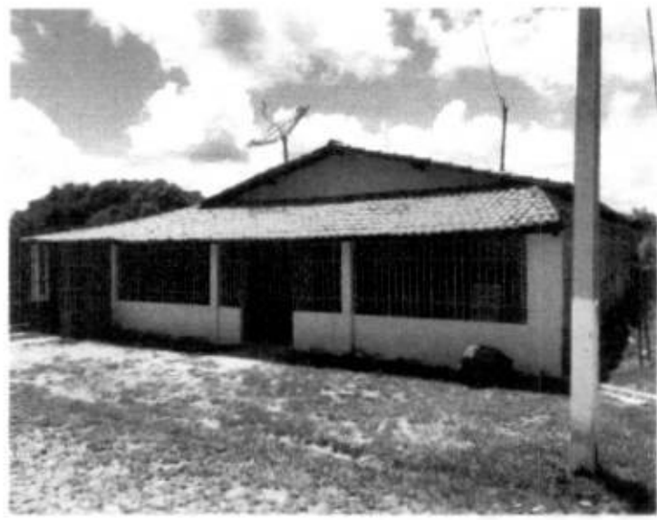
Foto 07: Fachada da Unidade
