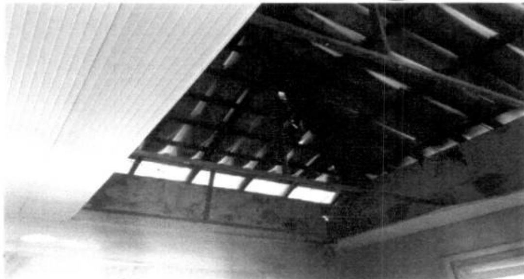
Foto 04: Forro de pvc com estrutura apolo com pontos de oxidação
