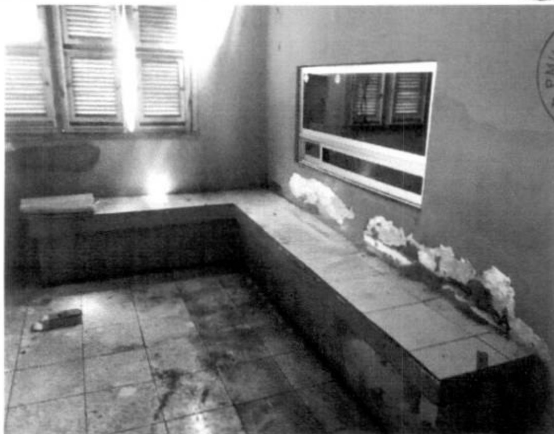
Foto 05: Ambiente com elevado desgaste da pintura tipo textura.
