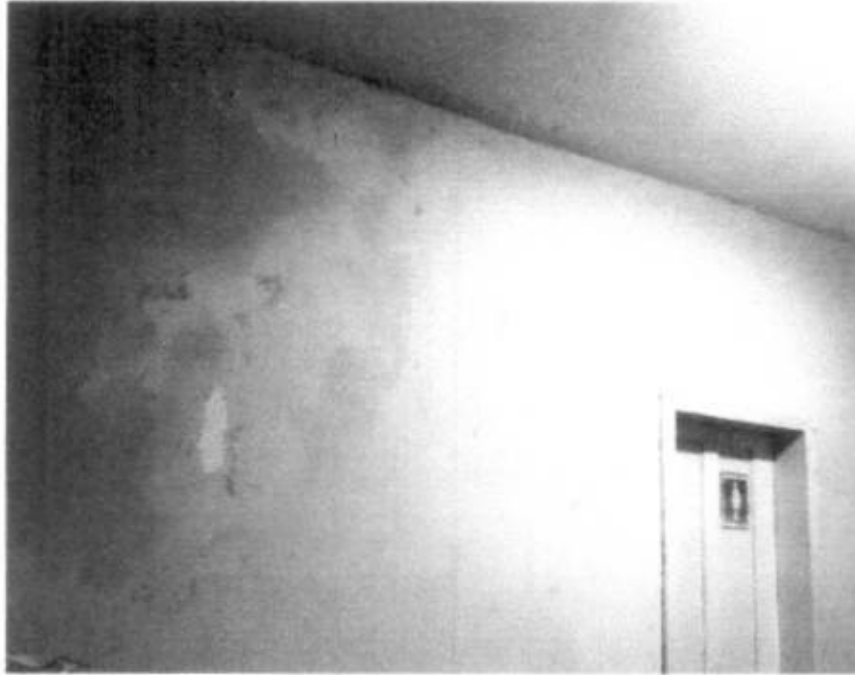
Foto 04: Umidade excessiva nas paredes.
