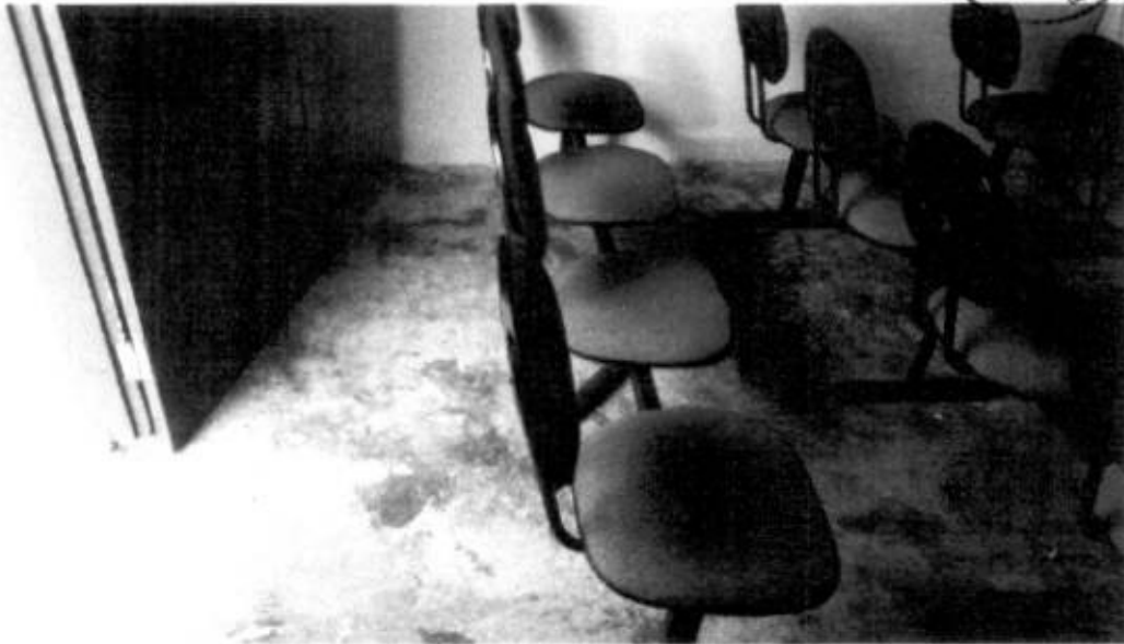
Foto 04: Desgaste do piso no setor de tributos
