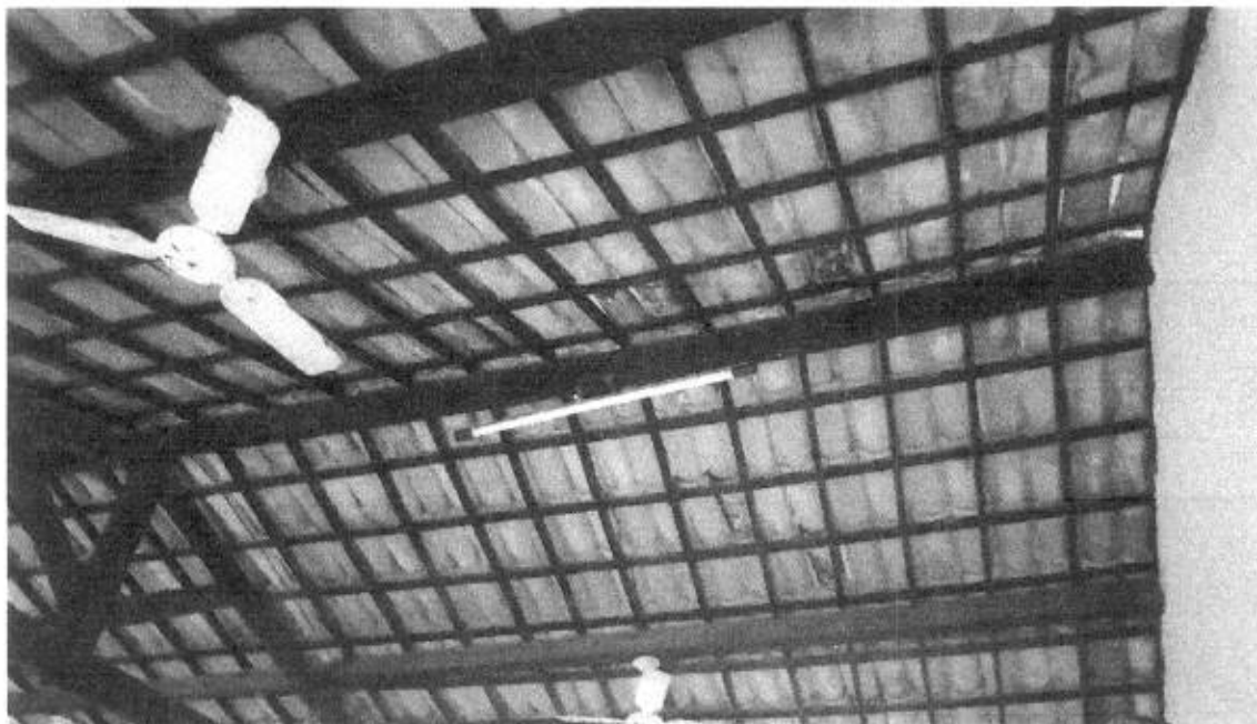
Foto 05: Telhas coloniais com elevado desgaste.
