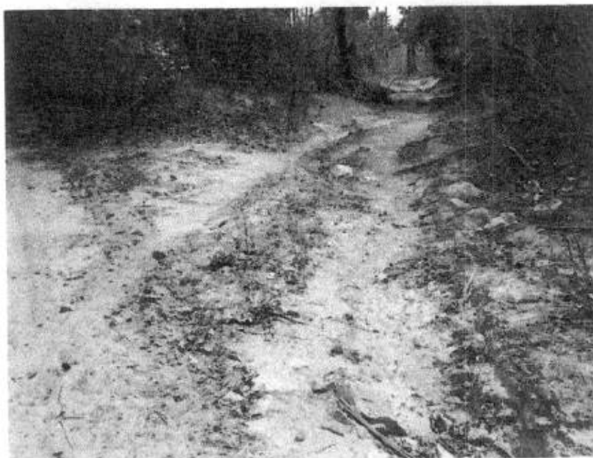
Foto 02 - local de interdição para construção de bueiros
