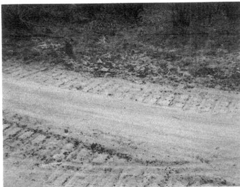
Foto 01 - local de interdição para construção de bueiros
