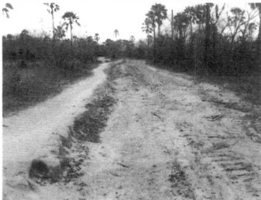
Foto 04 - exemplo da estrada que ao longo dos anos recebia como solução de problema raspagem e que está prestes a receber a terraplenagem.
