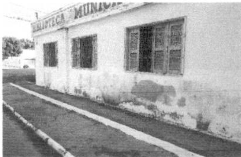
Foto 01: Fachada lateral da edificação
