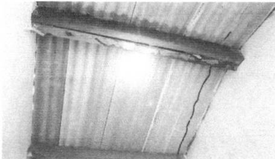
Foto 03: Presença de cupins no madeiramento da cobertura
