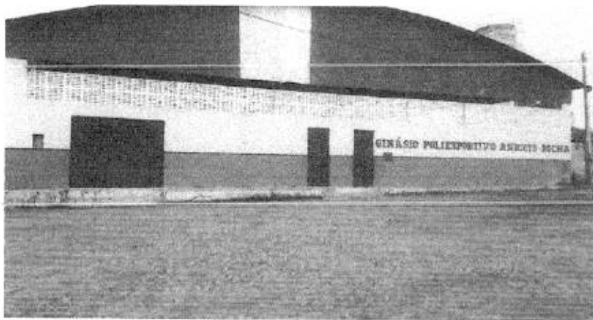
Foto 01: Fachada da edificação
