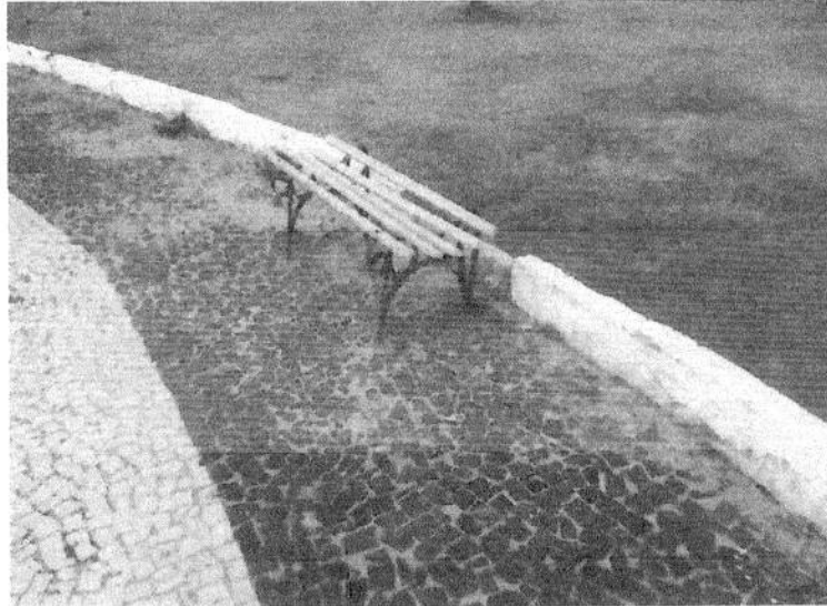
Foto 03: Bancos com madeiramento incompleto
