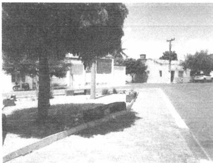
Foto 01: Perímetro da praça
