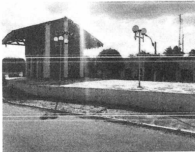
Foto 01: Fachada da edificação
