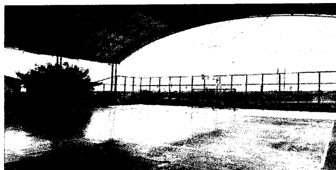
Foto 05: Piso da quadra
