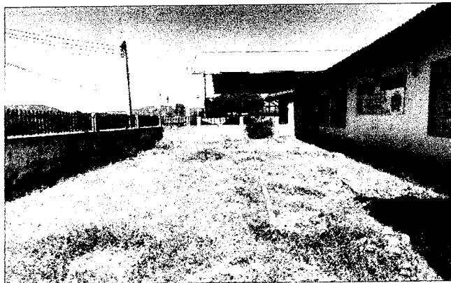
Foto 04: Local de implantação da área de convivência
