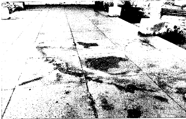
Foto 06: Piso industrial com desgaste superficial
