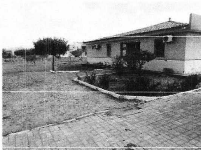
Foto 02: Área a ser pavimentada
