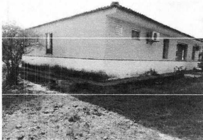
Foto 01: Fachada da edificação, com eflorescência da pintura
