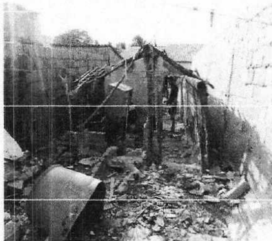
Foto 01: Local do sinistro
