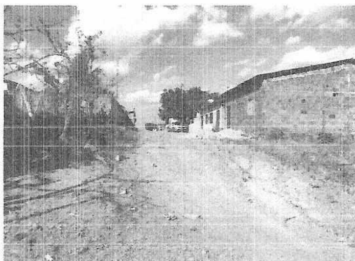
Foto 01: Local de implantação da pavimentação(RUA EDITHE LINHARES, DISTRITO DE PARACUÁ)
