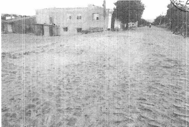
Foto 03: Pavimento com acentuado desnivelamento
